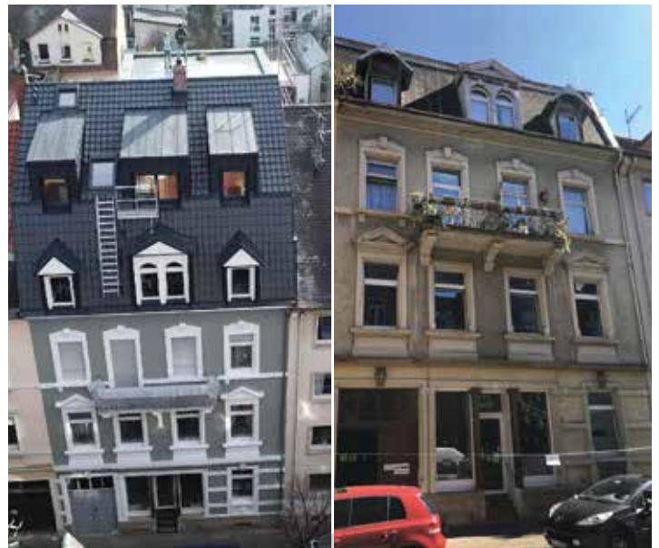
Vor und nach der Aufstockung in der Guntramstraße 43
