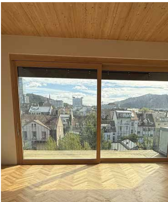
Blick aus dem Wohnzimmer mit 3,5 m Deckenhöhe und Brettstapeldecke
