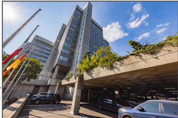
Bis etwa Mitte Februar 2023 sollen die Arbeiten andauern. Nach der Verlegung einzelner Versorgungsleitungen werden neben 38 Stahlbetonstützen auf den Parkdecks 1 und 2 Stahlprofile montiert, um die Standsicherheit des Gebäudes sicherzustellen und so unter einem jährlichen Monitoring das Stadthaus voraussichtlich bis 2026/2027 weiter nutzen zu können.
