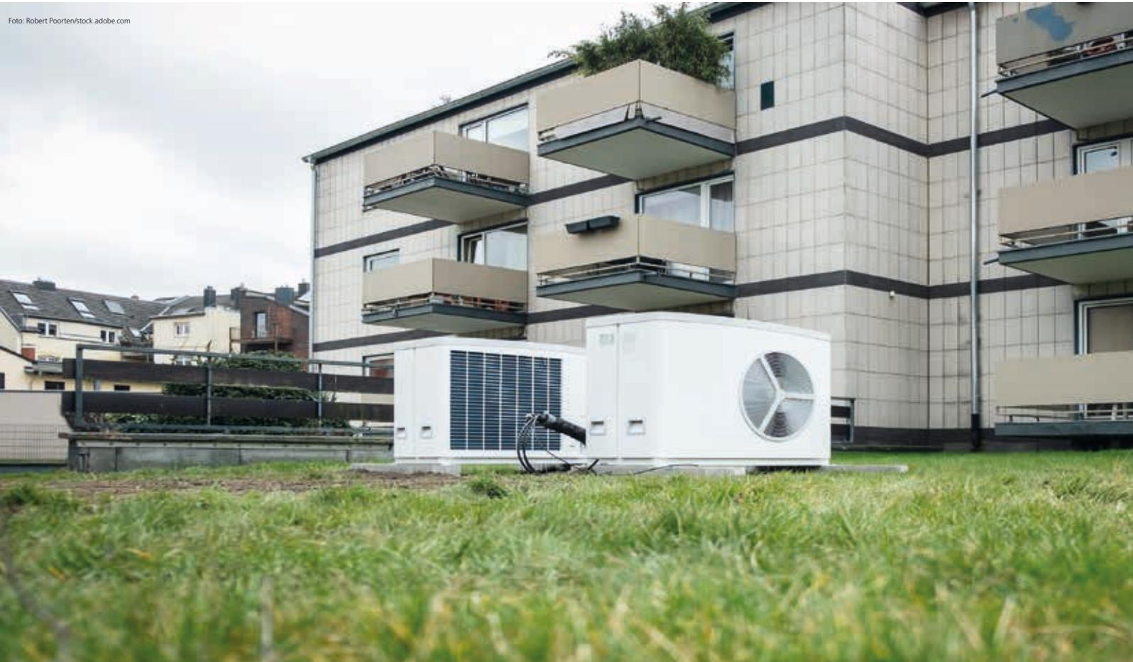
der Betrieb einer Wärmepumpe bereits ohne zusätzliches Heizsystem effizient und mit hoher Jahresarbeitszahl (JAZ) möglich. Die JAZ verbessert sich mit zunehmendem Sanierungsgrad: beispielhaft liegt die JAZ für ein Einfamilienhaus im unsanierten Zustand bei 2,75, für ein Gebäude im GEG-Standard bei 3,75, im BAFA-Standard bei 3,90 und beim Effizienzhausstandard EH55 bei 3,95.
