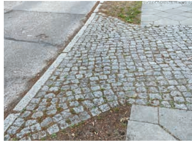
links: Gehweg mit Reihenpflasterung älterer Gehwegplatten aus Beton 30x30 cm, teilweise mit „Noppen“ zur Rutschhemmung (?), Markgrafenstraße, rechts: Gehwegüberfahrt mit Reihensteinpflaster aus Granit mit schwalbenschwanzförmiger Verbreiterung an der Bordsteineinfassung, Münchener Straße
