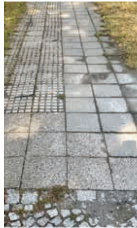
links: Gehweg mit Reihenpflasterung älterer Gehwegplatten aus Beton 30x30 cm, teilweise mit „Noppen“ zur Rutschhemmung (?), Markgrafenstraße, rechts: Gehwegüberfahrt mit Reihensteinpflaster aus Granit mit schwalbenschwanzförmiger Verbreiterung an der Bordsteineinfassung, Münchener Straße
