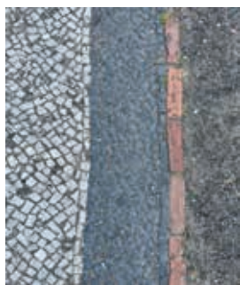
Pflaster an Pergola und Gehwegen auf dem Zeltinger Platz: Bernburger und Basalt-Mosaikpflaster (mit Ziegelsteinbegrenzung)
