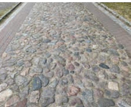
Lesestein-/Feldsteinpflaster, Dorfstraße, Stolpe
