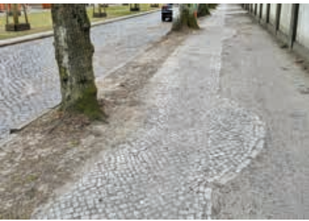
v.l.n.r.: Wiltinger Straße, Gehweg hochwertig in Mosaikpflaster ausgeführt, links Unterstreifen, rechts Oberstreifen, beide unbefestigt; Gehweg Bernburger Mosaikpflaster; Fahrbahn mit Basaltsteinen gepflastert, Bordstein aus Granit
