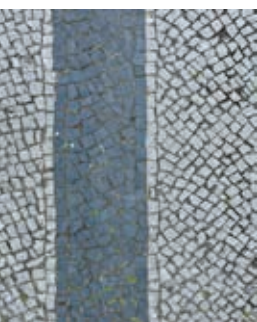
Pflaster an Pergola und Gehwegen auf dem Zeltinger Platz: Bernburger und Basalt-Mosaikpflaster (mit Ziegelsteinbegrenzung)
