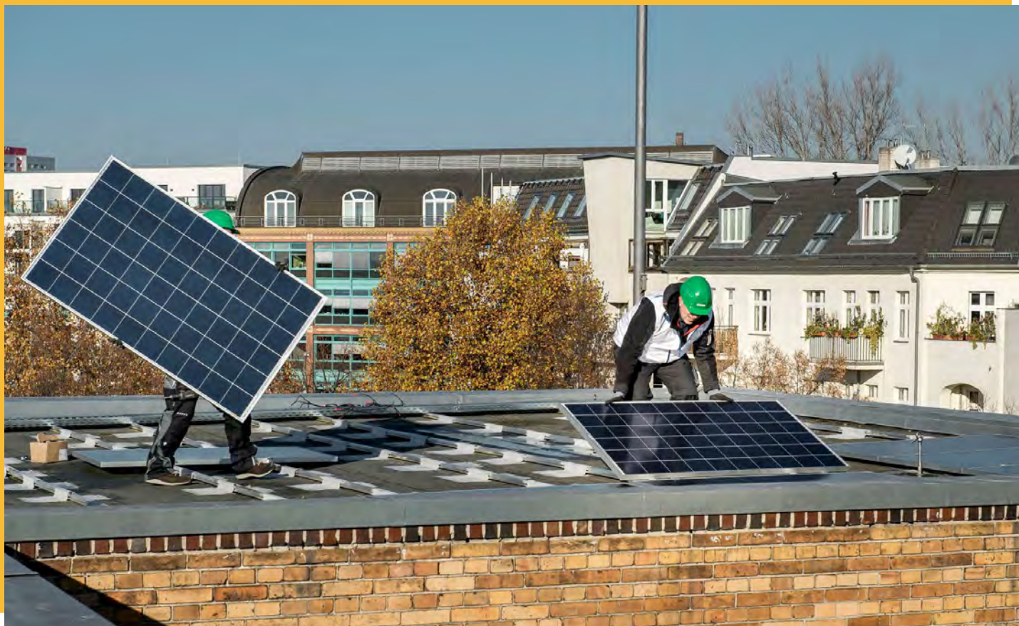
Abb. 15: Installation von Solaranlagen auf der Max-Taut-Schule (Foto: Berliner Stadtwerke GmbH | Benjamin Pritzkeleit)
